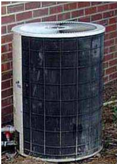
Gambar 3.99 Unit kondensasi
