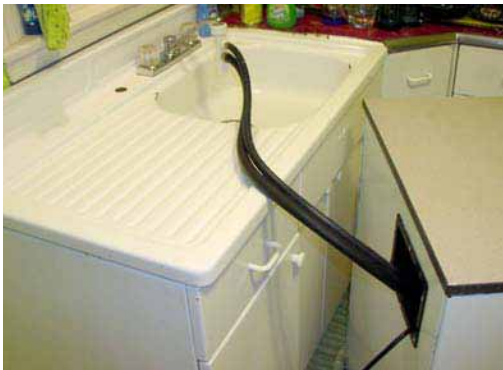
Gambar 3.44 Contoh penyambungan ke kran sumber air
