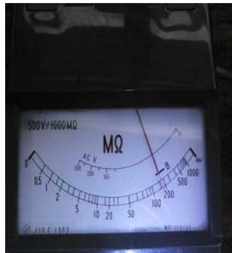
Gambar 5-4 Baterai dalam kondisi baik
