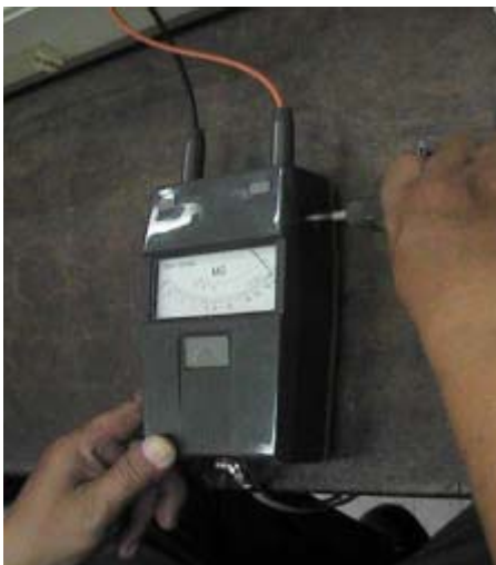
Gambar 5-3 Pengecekan kondisi baterai
