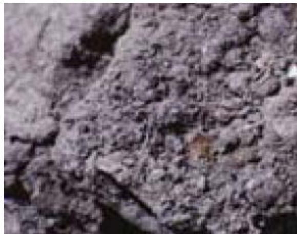
Gambar 5 – 12 Tanah yang korosif
