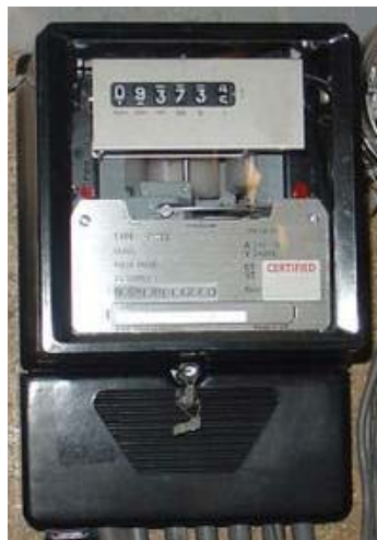
Gambar 4-24. Meter induksi elektromekanik, 100 A 230/400 V. cakram baling-baling aluminium horisontal merupakan pusat meter
