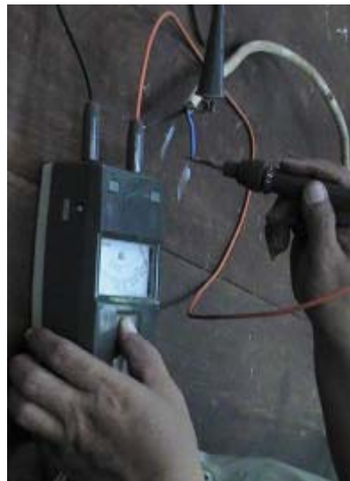
Gambar 5-6 Mengukur tahanan isolasi
