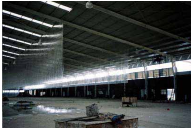
Gambar 7.27 Ventilasi di Pabrik
