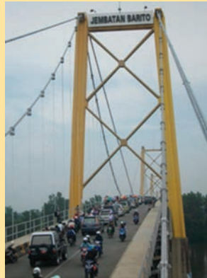
(ii) Jembatan Barito
