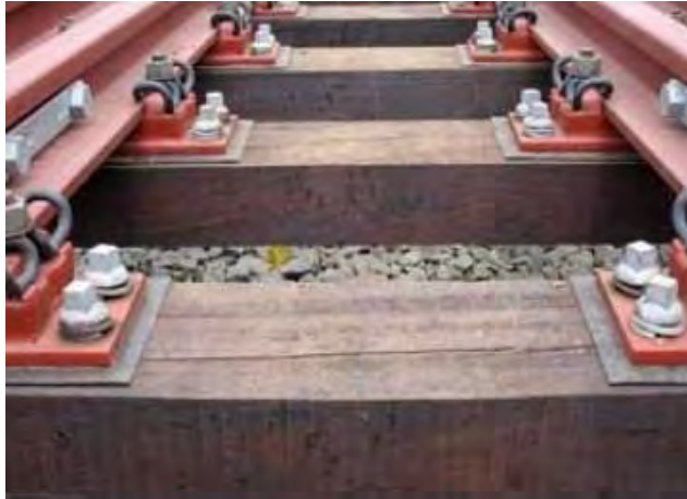
Gambar 24. Bantal rel kereta api berbahan kayu untuk meredam getaran (sumber: www.google.com )
