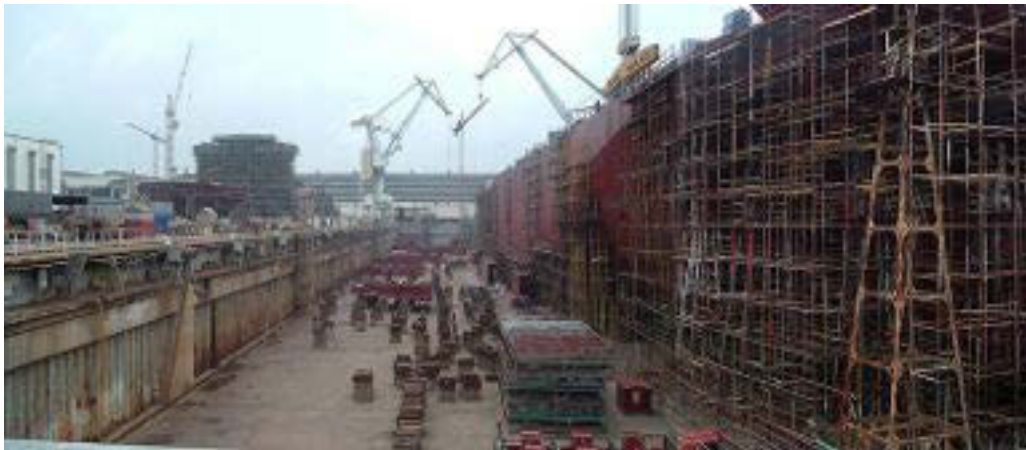
4.1 Kapal yang sedang dibangun di galangan Gdynia Shipyard
