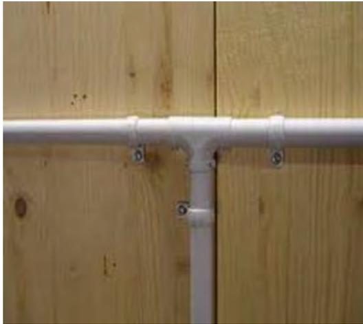
Gambar 1.11. Sambungan pipa cabang
