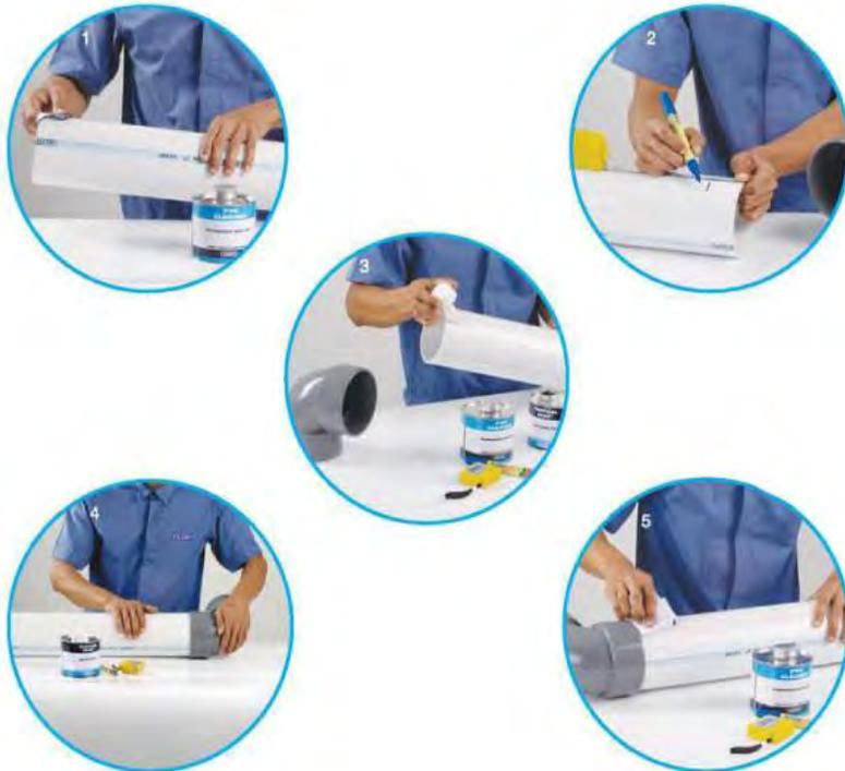
Gambar 1.10. Menyambung pipa PVC
