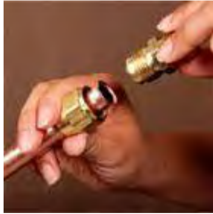
Gambar 4.7 Prinsip Penyambungan Pipa dengan Flare fitting
