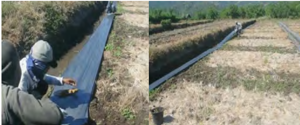
Gambar 6. Pemasangan MPHP
