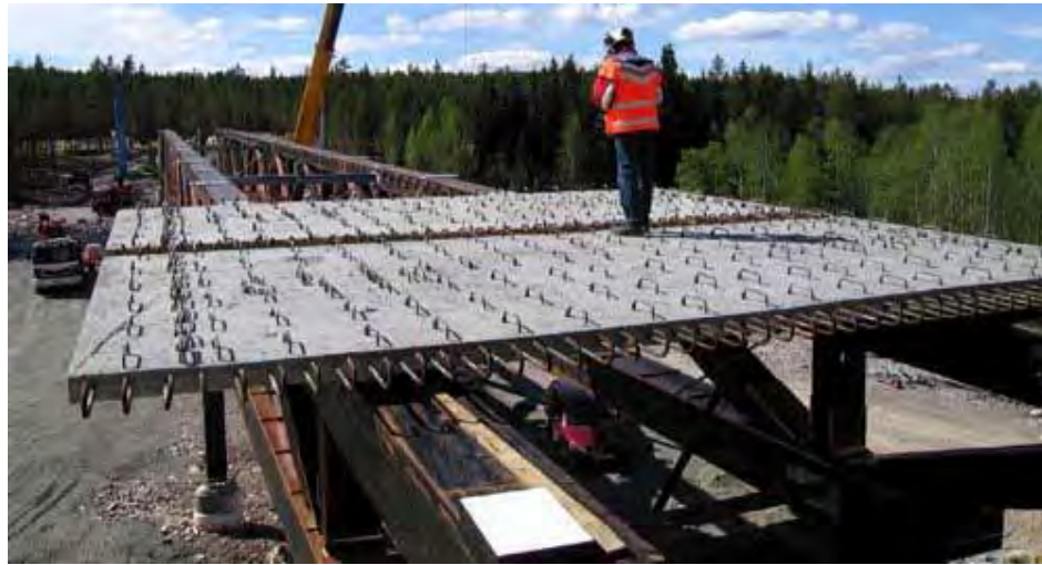
Gambar 7.14 Pemasangan lantai precast di atas jembatan kayu.
