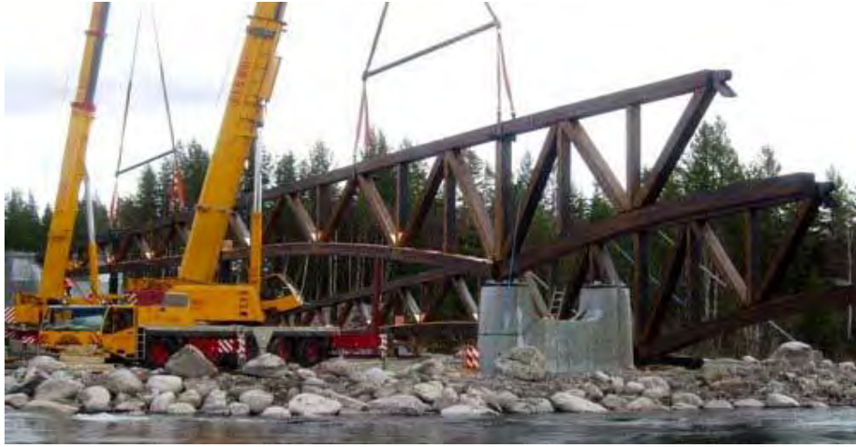
Gambar 7.12 Erectionjembatankayulaminasi.
