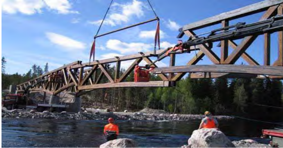
Gambar 7.13 Proses erection jembatan kayu sungai Rena
