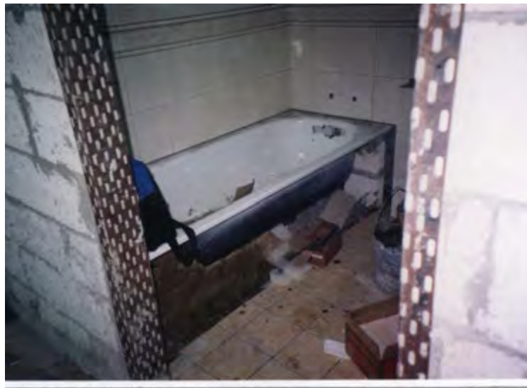
Gambar 8.18 Pemasangan Bath tub
