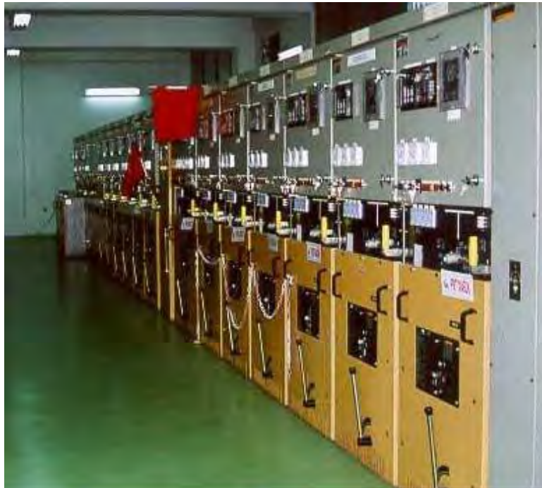
Gambar 3- 14. Cubicle 20 kV.
