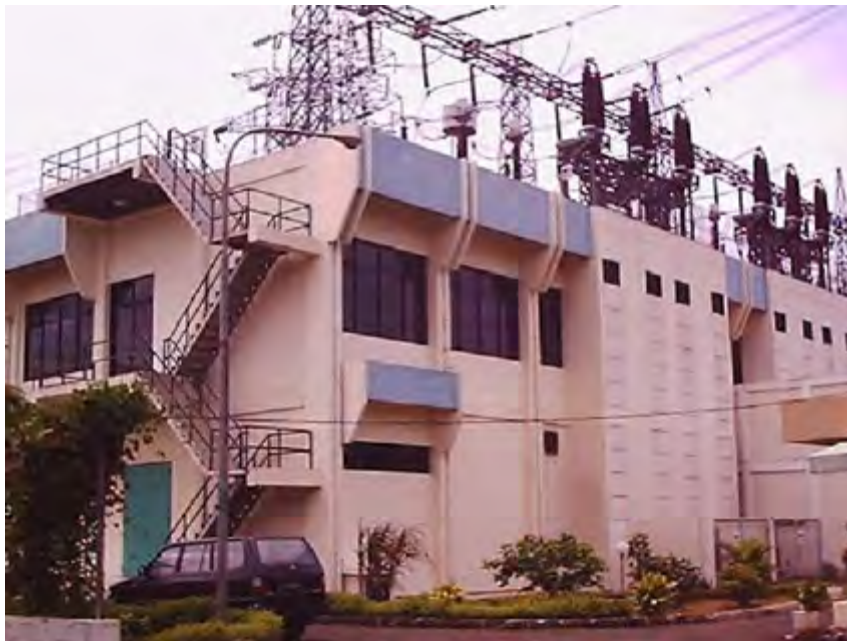
Gambar 3-10. Gedung kontrol GIS.
