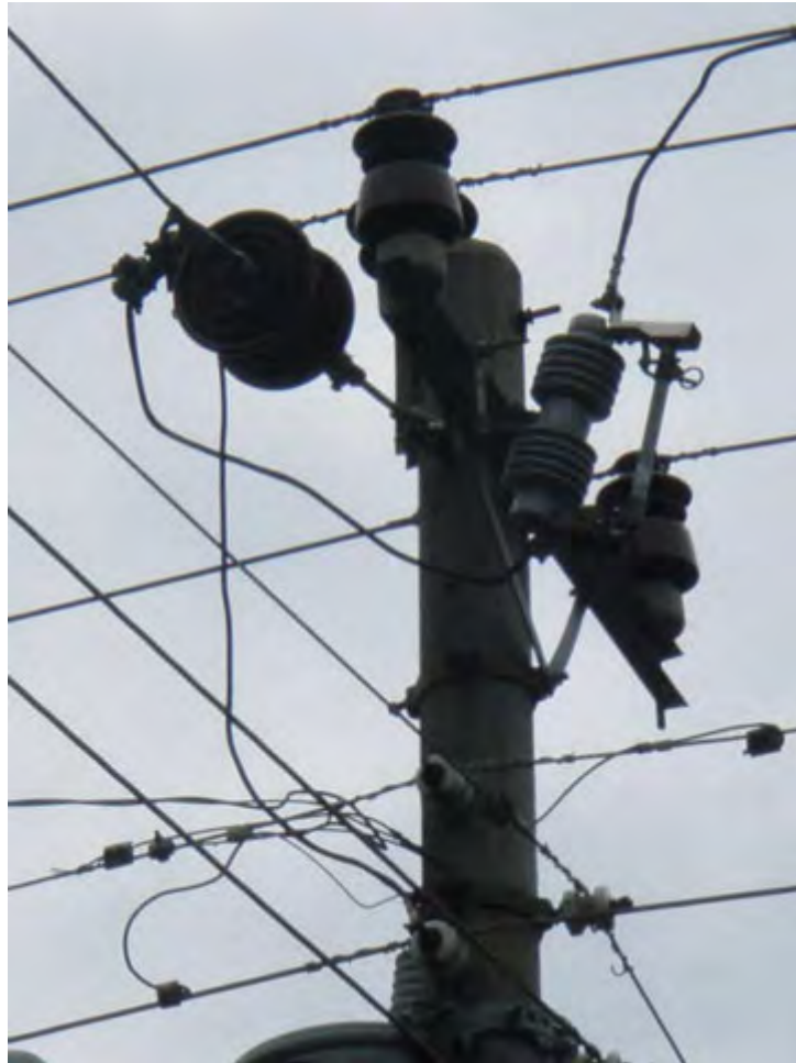
Gambar 4-11. Fused Cut Out (FCO).
