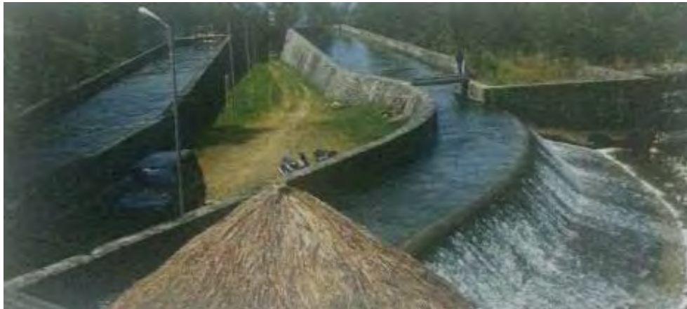
Gambar 6. Bendungan Walesi Papua
