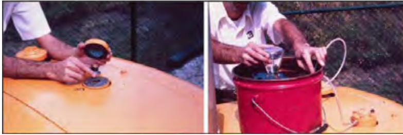
Gambar 10.109 Pemeriksaan gas pada sistem pendingin
