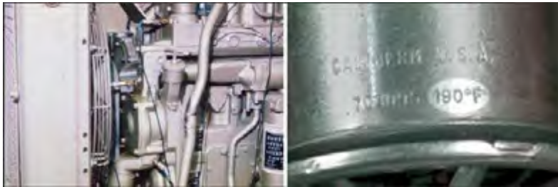
Gambar 10.103 Thermostat
