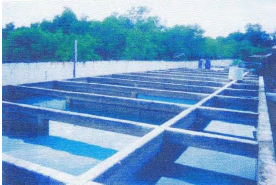
Gambar 13. Bak sedimentasi yang bersekat – sekat
