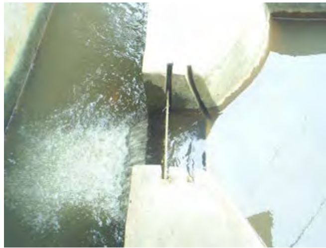
Gambar 11. Pintu pengeluaran air tipe Monik.
