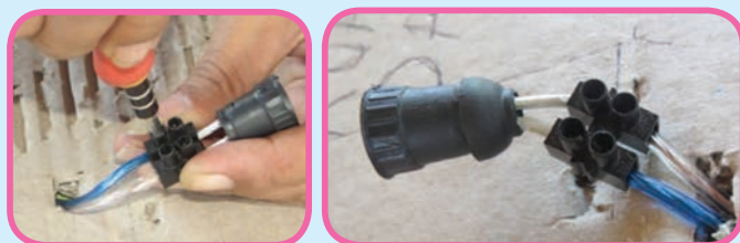
Sumber: Dokumen Kemdikbud Gambar 2.41 Pemasangan stand lampu lombok.
